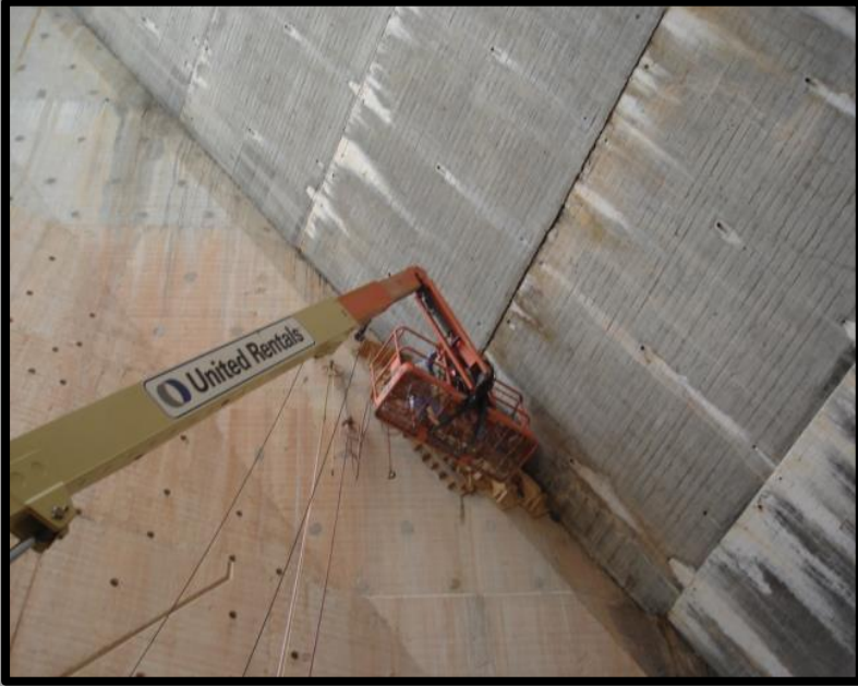
Grout pour from man lift
