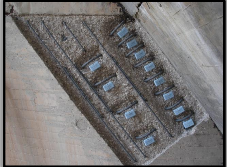
New rebar & zinc anodes
